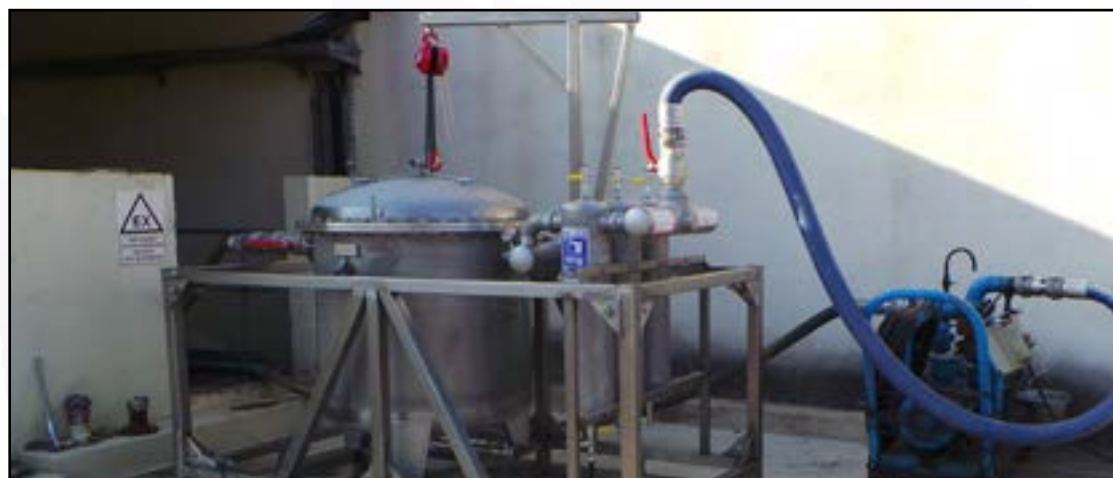
INSTALLATION VON EINEM FB1000 SYSTEM AN EINEM TREIBSTOFFSPEICHER INSTALLATION OF A FB1000 SYSTEM ON A FUEL STORAGE
